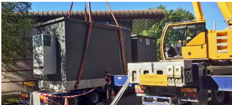
Pause d'un nœud de raccordement à la fibre optique
